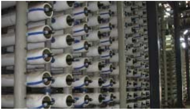
Fig. 7. Vista interior de uno de los edificios de membranas.
