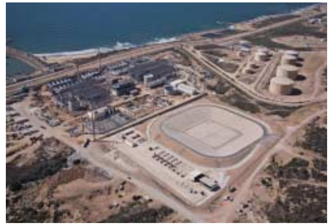
Fig. 2. Vista aérea de la planta desaladora de agua de mar de Ashkelon (Israel), en fase de construcción.
