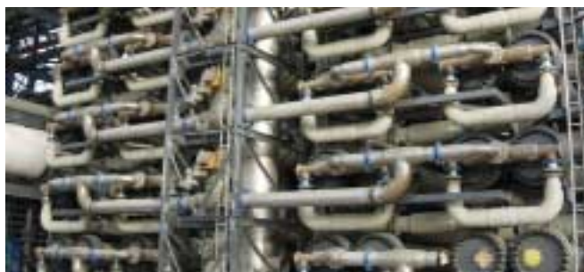
Fig. 6. Sistema de recuperación de energía.
