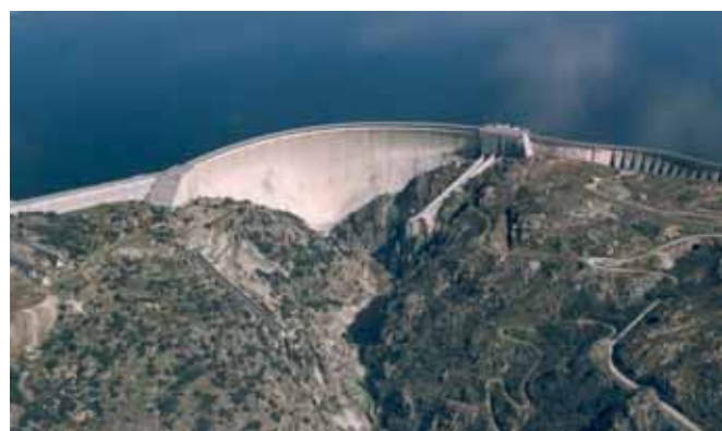
Fig. 7. Presa de la Almendra. La presa más alta de España, con 202 metros. Bóveda.
