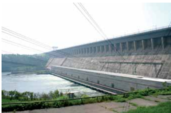
Fig. 2. Presa de Bratsk. Río Angara. Siberia.
