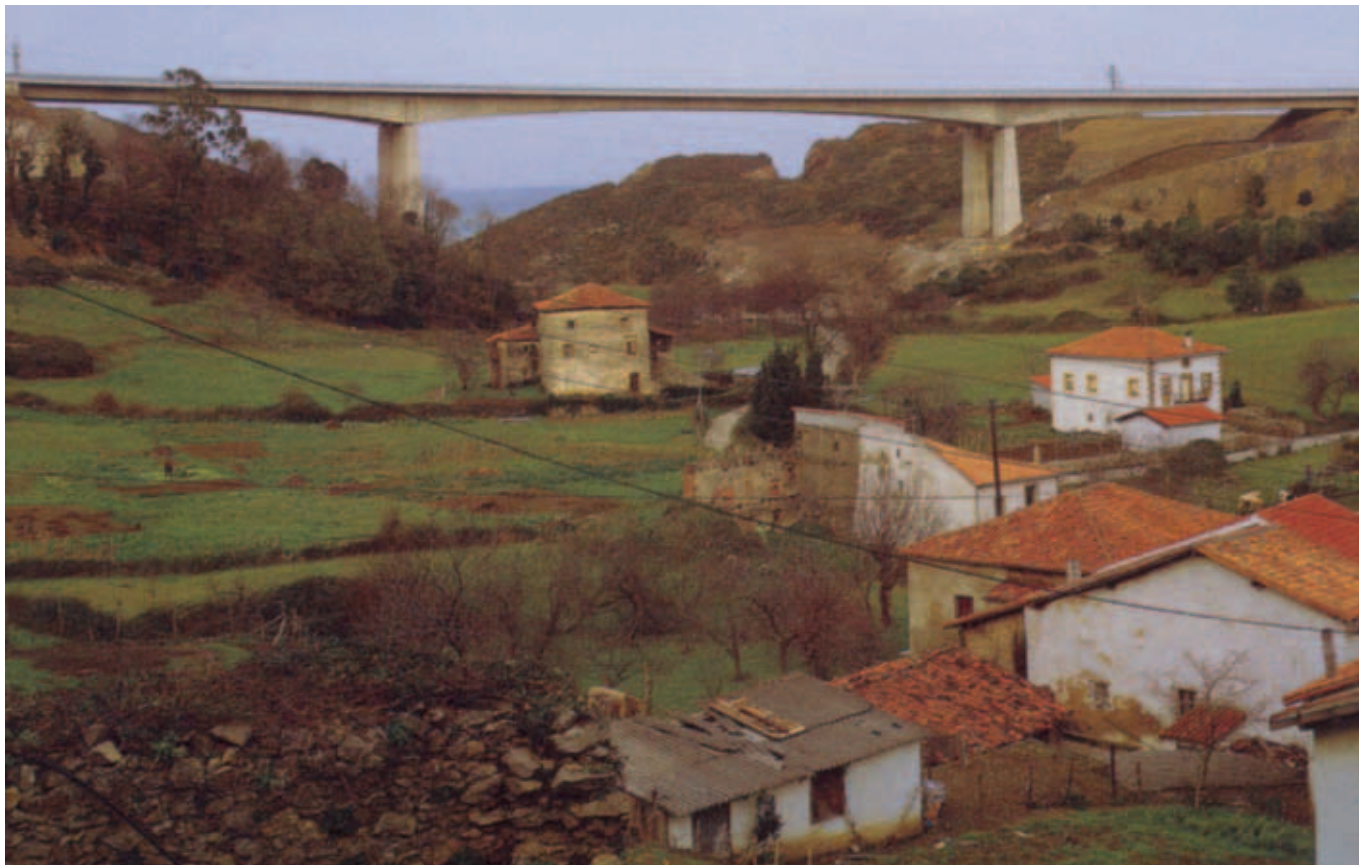
Fig. 9. Viaducto de Ontón, construido por voladizos sucesivos.
