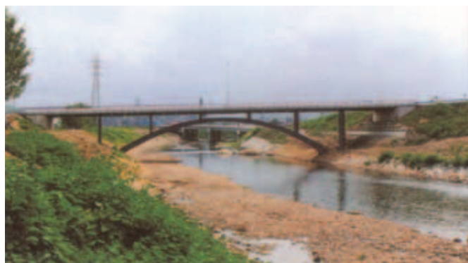
Fig. 7. Viaducto sobre el río Saja de acceso a Ganzo.
