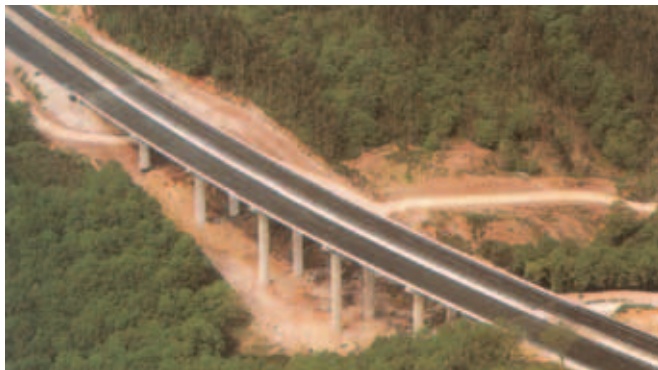
Fig. 5. Viaducto de Caranceja.
