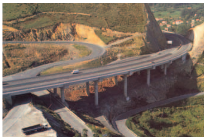
Fig. 4. Viaducto de Saltacaballo.
