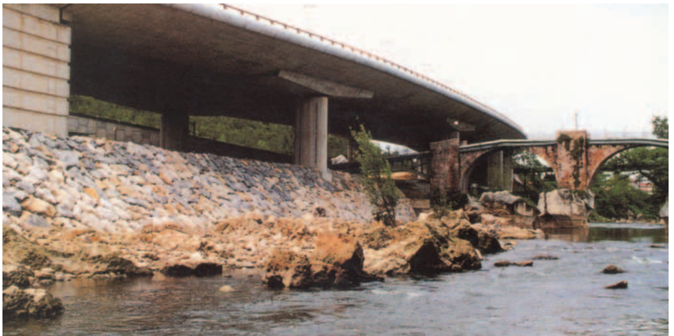
Fig. 6. Viaducto de Torres y puente viejo de acceso a Ganzo.
