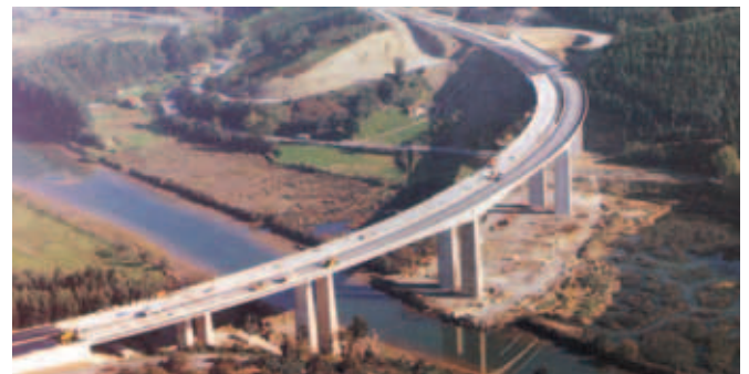
Fig. 10. Viaducto del río Agüera, construido por voladizos sucesivos.
