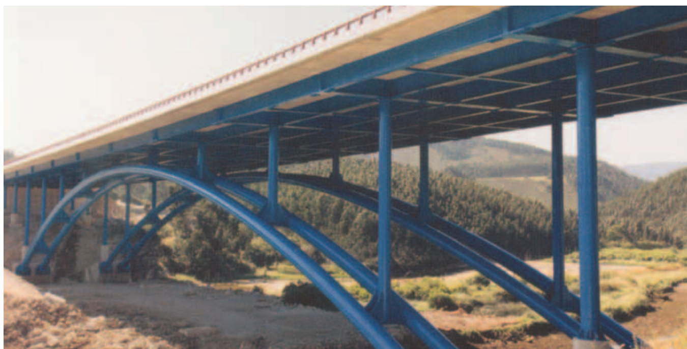
Fig. 8. Viaducto del río Escudo.
