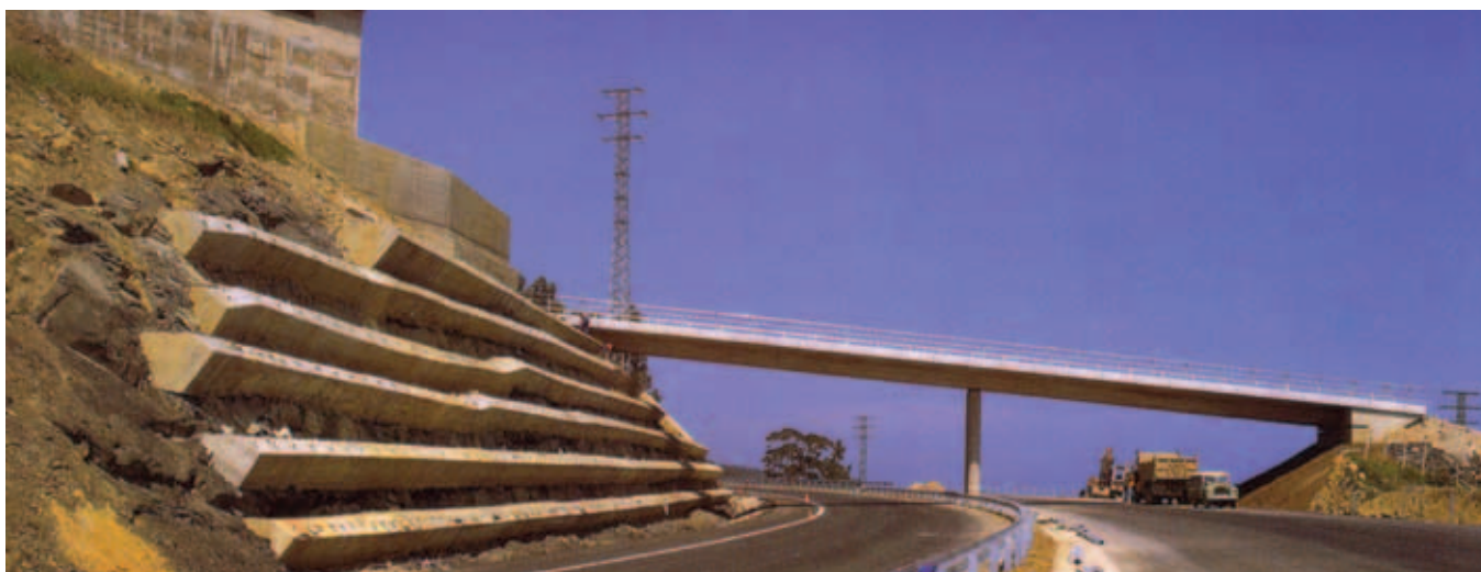
Fig. 2. Muro anclado junto al depósito de agua de Castro Urdiales.
