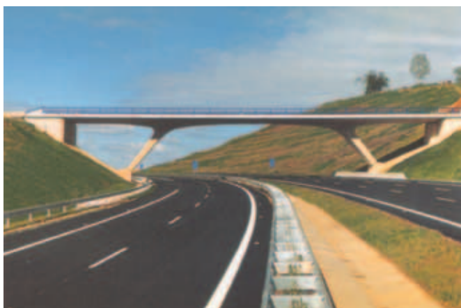
Fig. 3. Paso superior con pórtico en forma de letra griega "pi".
