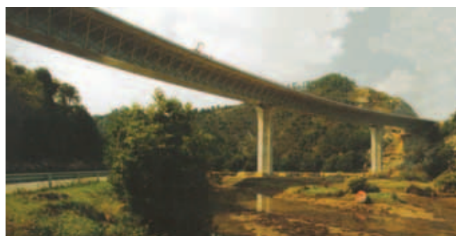
Fig. 14. Viaducto de la ría de Tina Menor.
