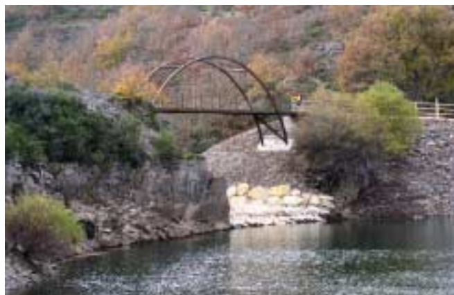
Fig. 1. Pasarela en acero corten situada en el arroyo Amarillas, en el CN de la Vía Verde de la Sierra de la Demanda (Burgos). El piso es de tabloncillos tanalizados, y los pendolones son de redondo de acero inoxidable.
