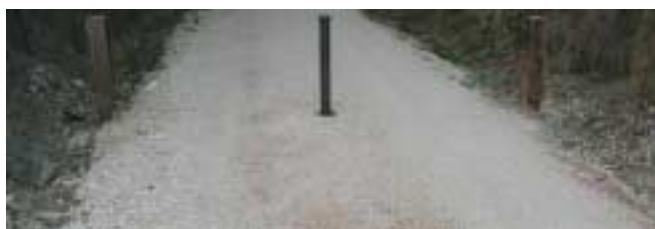
Fig. 8. Ejemplo de firme asfáltico con ligante sintético transparente. El tono que se aprecia es el del árido. Arriba de la foto se ve un bolardo desmontable flanqueado a ambos lados por dos traviesas empotradas verticalmente, que son hitos fijos para evitar la entrada al CN de vehículos motorizados.
