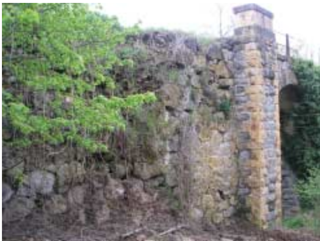
Fig. 4. Estribo del puente del antiguo Ferrocarril Vasco-Navarro sobre el río Sabando (Álava), incluido en el CN Vasco-Navarro, antes de su rehabilitación.
