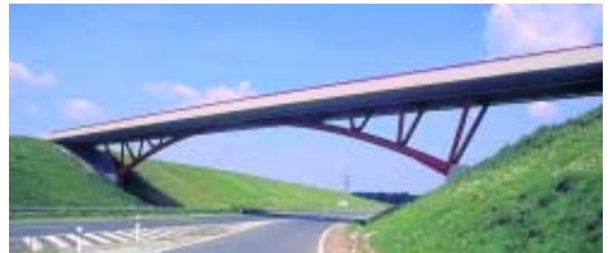
Fig. 21. Paso superior sobre autopista en la República Checa, de Jirí Strásky.
