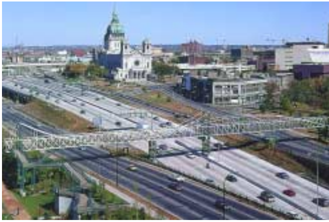
Fig. 8. Irene Hixon Whitney bridge (Minneapolis, Minnesota), de Siah Armajani. Vista panorámica.
